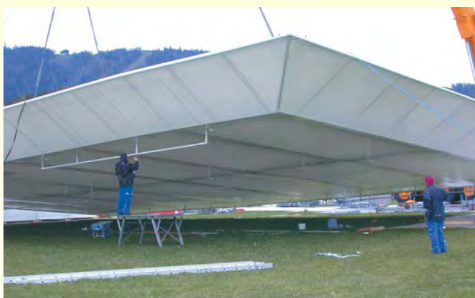
Aufziehen des riesigen, 21 x 38 Meter großen Daches
