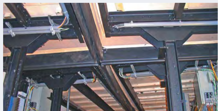
Scherkantenschutz-Sicherheitsleisten an allen Podienkanten
