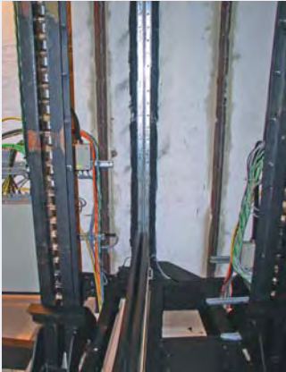
Die neuen Führungsschienen (in Bildmitte)
