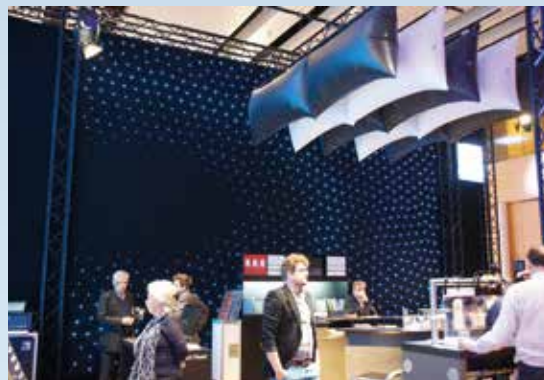
Mit solchen Akustik-elementen des AqFlex-Absorbersystems von Gerriets wurde beim Songcontest die Raumakustik verbessert
