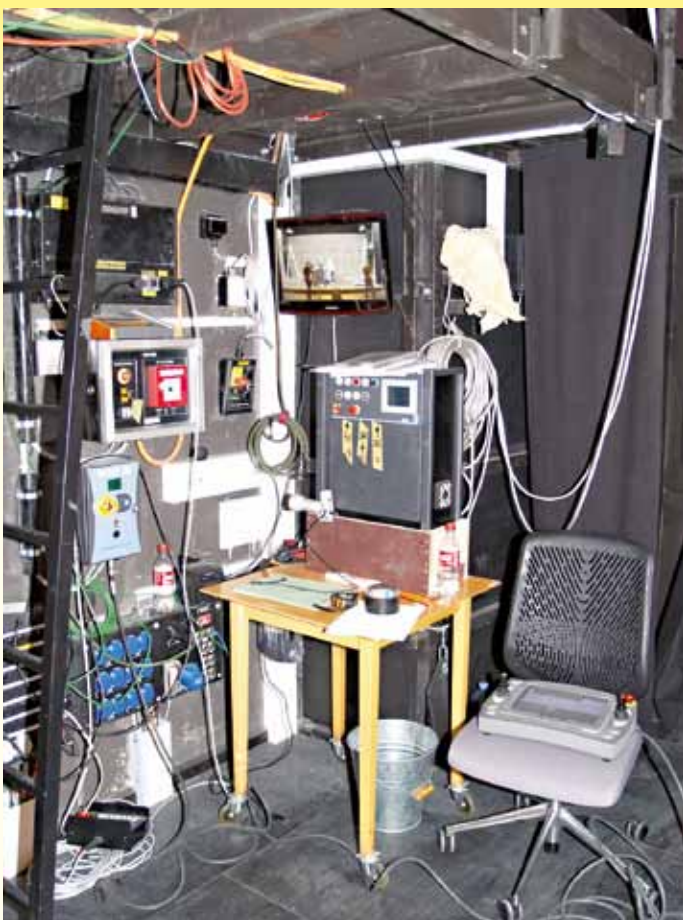
Eine der zwei Steckstellen für die bühnentechnische Steuerung beim rechten Portalturm – Am Sessel das CAT V4-Pult
