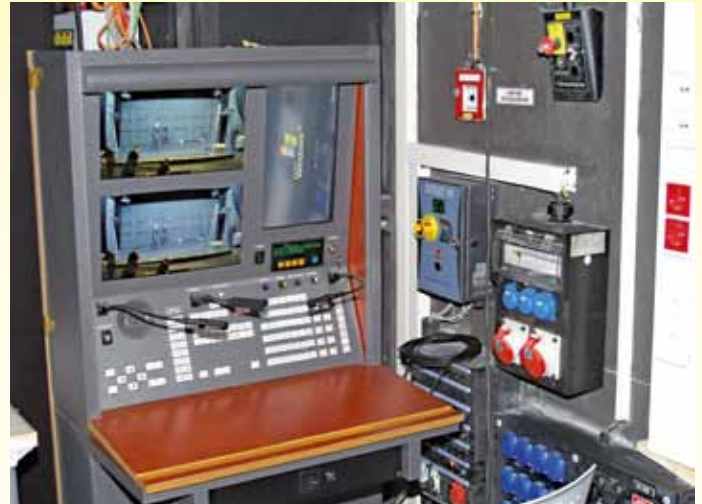
Das Inspizientenpult – rechts die Vorhangsteuerung mit der Notauslösung
