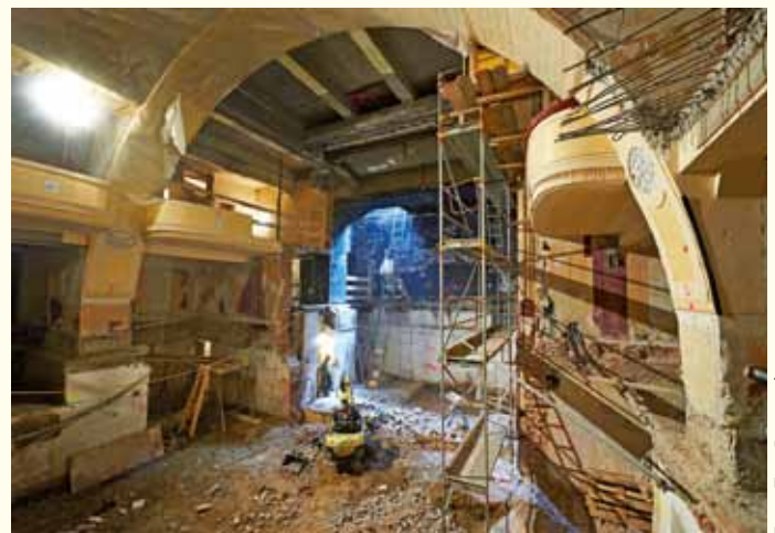
Das Theater wurde komplett entkernt – im Hintergrund die Einbringöffnung für das gesamte Material
