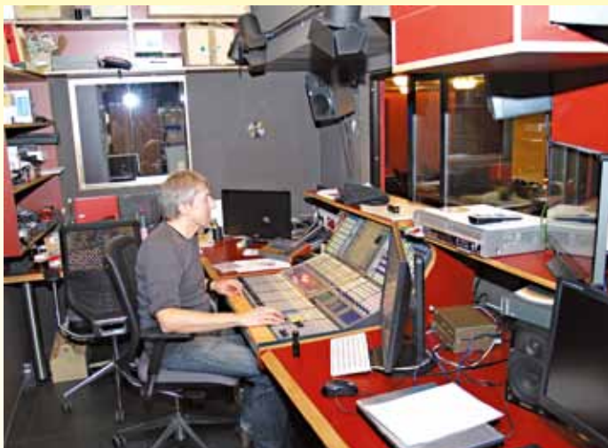
Der neu errichtete Tonregieraum – in ihm ist das erweiterte CAS Mix-Pult installiert
