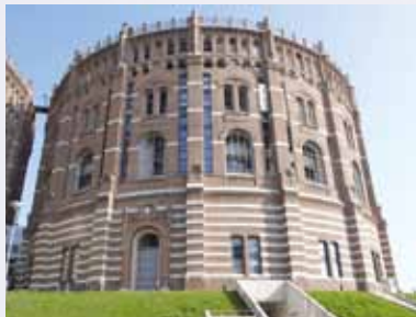
Die neue Firmen-Niederlassung von „Klangfarbe“
