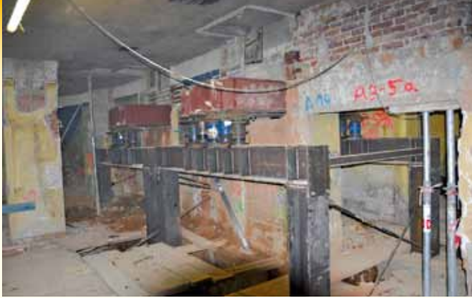
Die Hauptstützen des Zuschauerhauses mussten auf Stahlblöcke umgelastet werden, um darunter die Fundamente erneuern zu können
