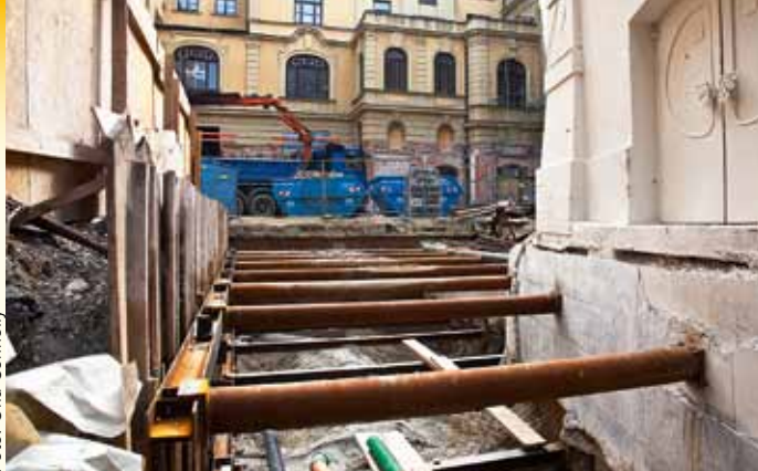
Der gesamte Bodenbereich musste statisch ertüchtigt und alle Fundamente mussten verstärkt werden
