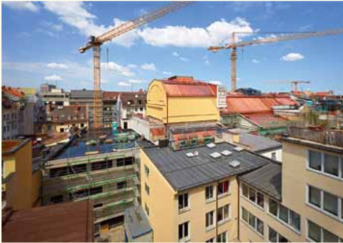
Die neuen Dachkonstruktionen wurden im Sommer 2011 fertiggestellt und sind kupferverkleidet
