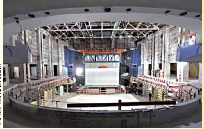
Der Zuschauerraum wurde bis auf das Beton- und Stahlskelett entkernt
