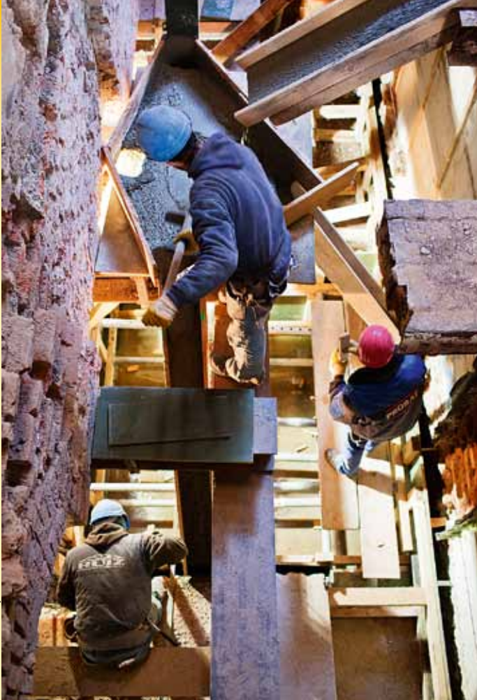
Der gesamte Bodenbereich musste statisch ertüchtigt und alle Fundamente mussten verstärkt werden
