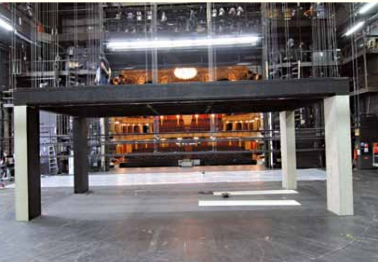
Das nun über zwei Winden betätigte Doppelstock-Hubpodium
