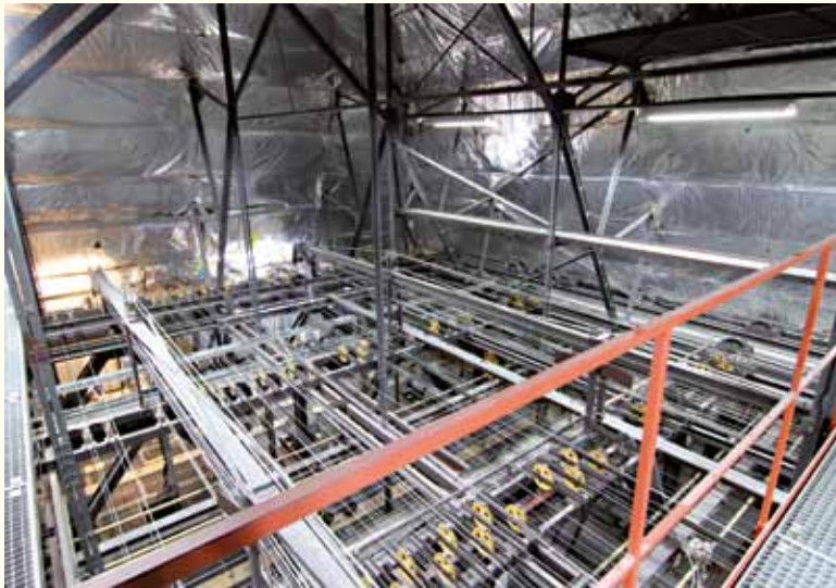
Die unzähligen Seile am alten Schnürboden
