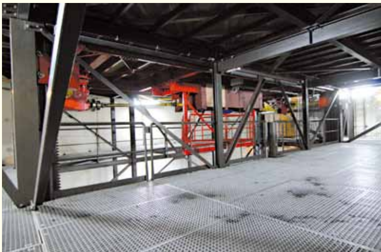
Das Doppelstock-Hubpodium mit dem alten, sehr lauten Zahnstangenantrieb
