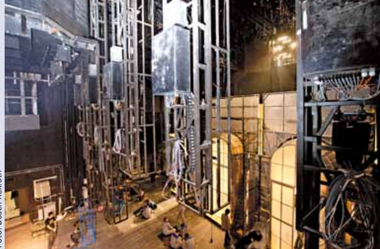
Die teleskopierbaren Seitenlichter können sowohl vertikal als auch horizontal verfahren werden und leuchten die Szenerie von der Seitenbühne aus
