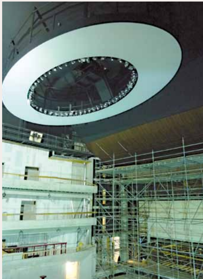
Die Unterseite der ovalen Beleuchterbrücke ist gleichzeitig der Kronleuchter des Zuschauerraumes
