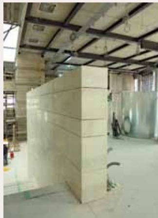
Brüstungen und Geländer werden im Foyer bereits mit Marmorplatten verkleidet
