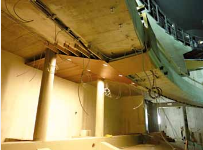
Das erste Musterelement der Brüstungsverkleidung im Zuschauerraum
