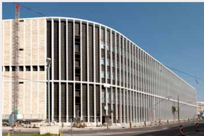
Das Theater wird mit Travertin-Stein eingehüllt
