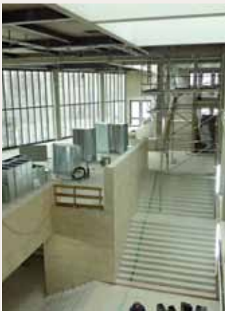
Brüstungen und Geländer werden im Foyer bereits mit Marmorplatten verkleidet
