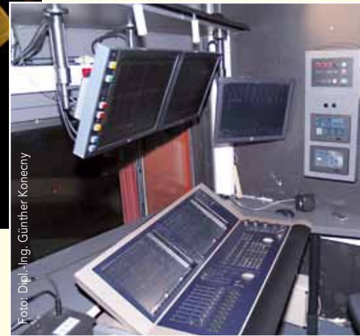
Rechts an der Wand die ETC-Paradigm-Anlage für das Allgemeinlicht mit zwei Touchscreens
