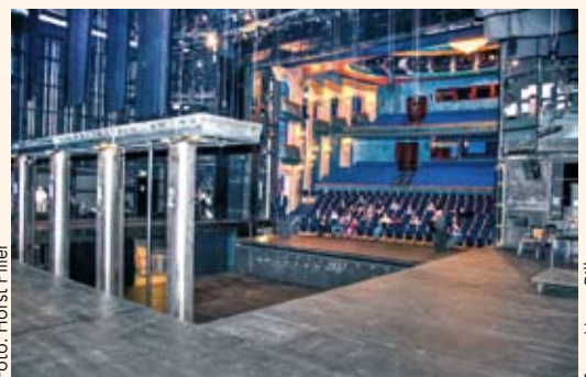
Mit den 72 Podien lassen sich die unterschiedlichsten Bodenprofile herstellen
