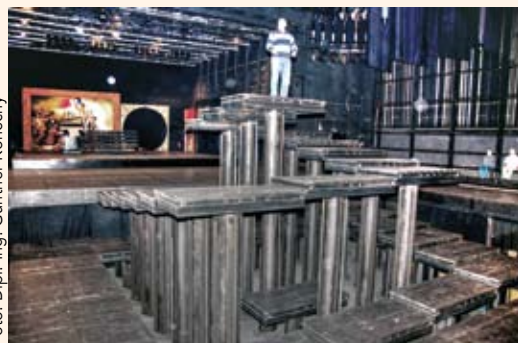
Mit den 72 Podien lassen sich die unterschiedlichsten Bodenprofile herstellen
