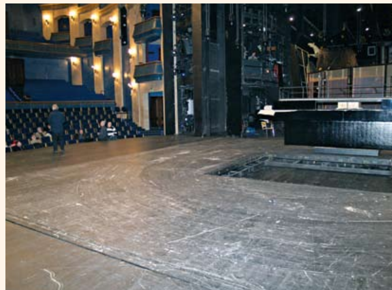
Der auf der Bühne abgesenkte Wagen mit 4 x 4 m großer Mittenöffnung
