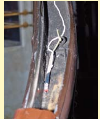
Handlauf mit abgenommener Abdeckung und eingelegter Zündschnur
