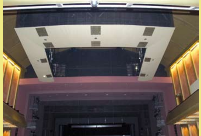
Die Beleuchterbrücke in Untersicht. Sie fügt sich harmonisch ins Erscheinungsbild der Decke ein.
