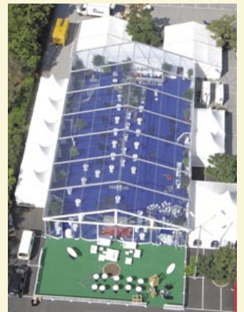
Das Festzelt mit Glasdach und Terrasse
