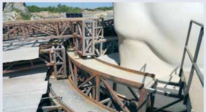
Die ringförmigen Wannen trugen das obere Ende der Flügelelemente
