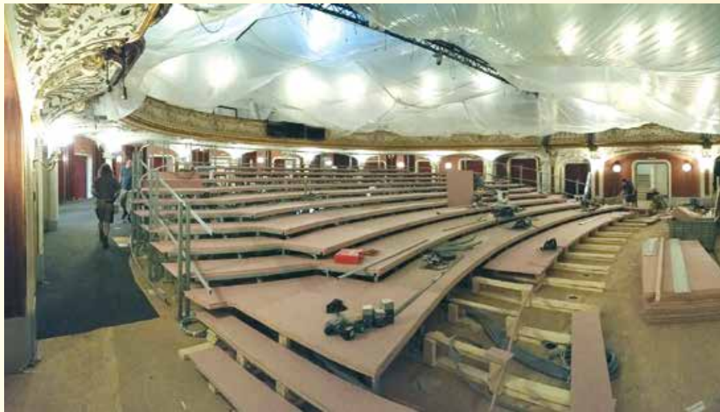
Das beplankte Gerüst
