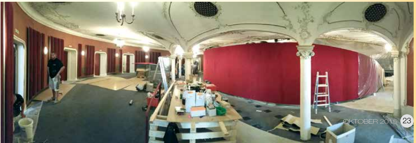
Die auf der Rückseite verkleidete Tribüne
