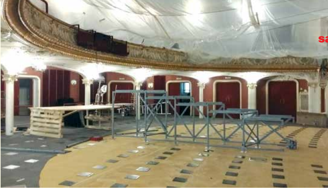
Der zerlegbare Tribünen-Unterbau als Stahlgerüst
