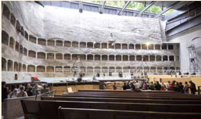
Die „Felsenreitschule“ mit der neuen Dachkonstruktion ...
