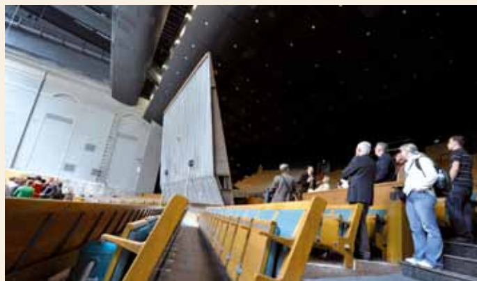
Hochgeklapptes Tribünenelement in der „Felsenreitschule“
