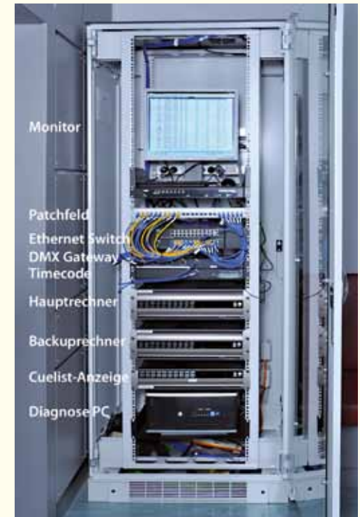
oben: Der Netzwerkschrank und seine Komponenten
