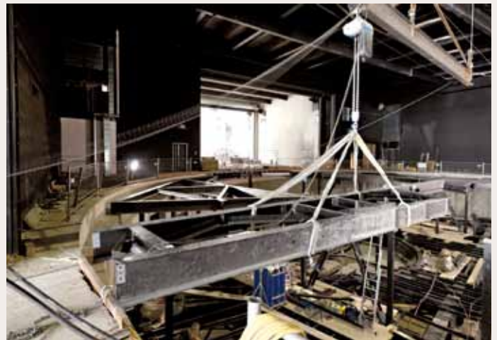
Die Transportdrehbühne in einer weiter fortgeschrittenen Bauphase
