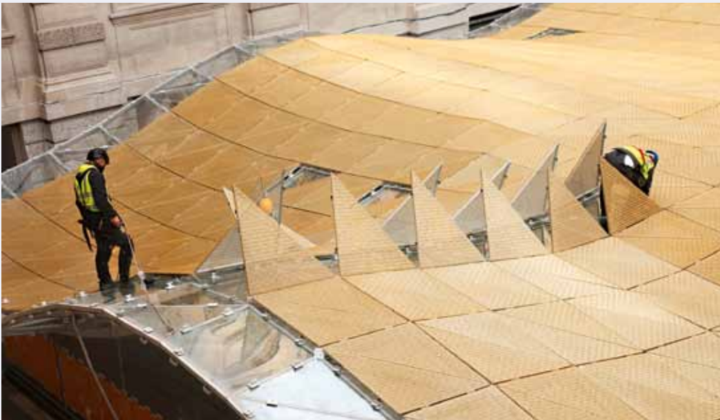
2.352 unterschiedliche Streckmetallpaneele wurden für das Dach benötigt
