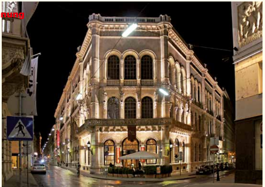
Blick auf das Café Central, Ecke Herrengasse/Strauchgasse; hier kommt die Fassadenanstrahlung besonders gut zur Geltung
