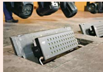
Der Einbau erfolgte in die bestehenden Bodenklappen
