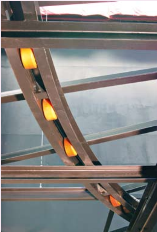
Der Unterbau mit den Rollen, auf denen die Scheibe läuft
