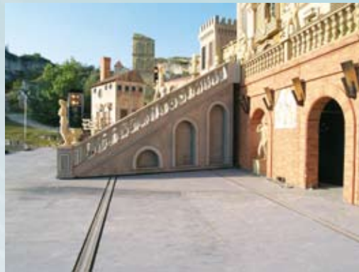
Die Häuser und die Freitreppe waren auf drei Schienen verschiebbar
