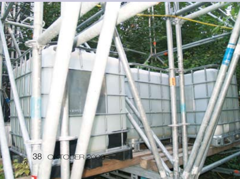
Überall mussten große Wassertanks als Ballast eingesetzt werden
