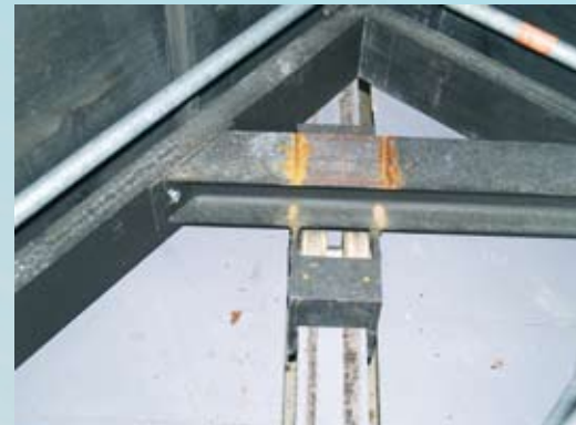
Die mit Rollen versehene Tragekonstruktion des Rigoletto-Hauses
