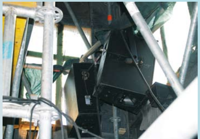
Zwei d&B Q7-Lautsprecherboxen hinter den Fenstern des Rigoletto-Hauses
