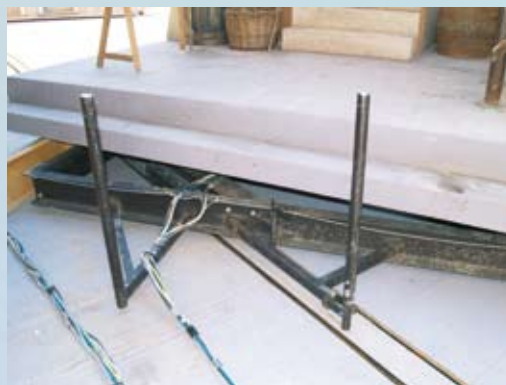
Die einfache Verriegelung der Häuser: Der rechte, bewegliche Bolzen schleift auf der Schiene, bis er ins Positionierungs-Loch fällt und die Fahrt stoppt
