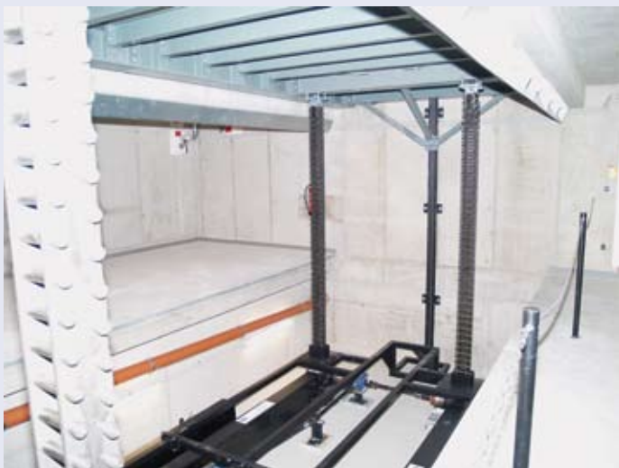
Hubpodium mit Serapid-Schubketten-Antrieb
