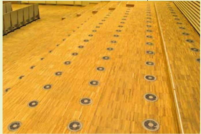
Die Drall-Auslässe für die Luftzufuhr auf der Tribüne
