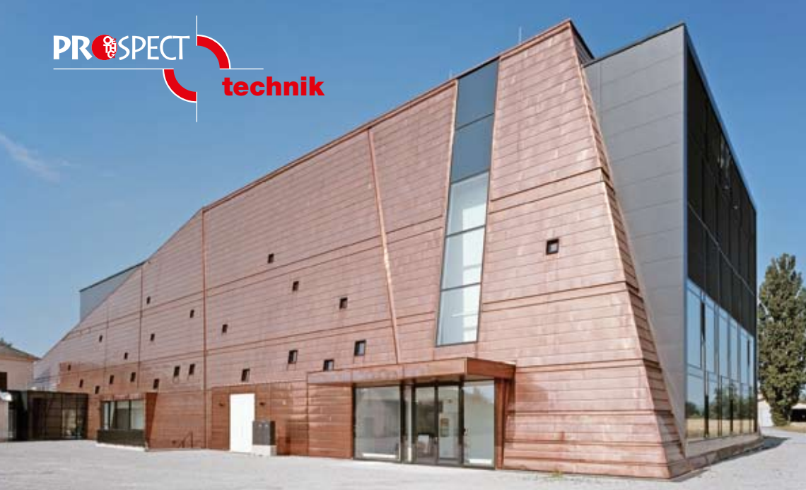
Außenansicht des Kupfer-verkleideten Auditoriums
