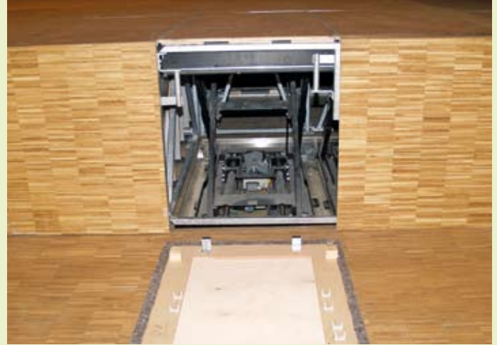
Eines der beiden motorisch betriebenen Spindelhubpodien
