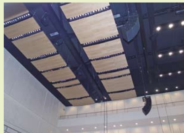
Die hochgezogenen Akustiksegel
