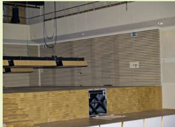
Deutlich zu erkennen ist die wellenförmig ausgeführte Seitenwand im Bühnenbereich
