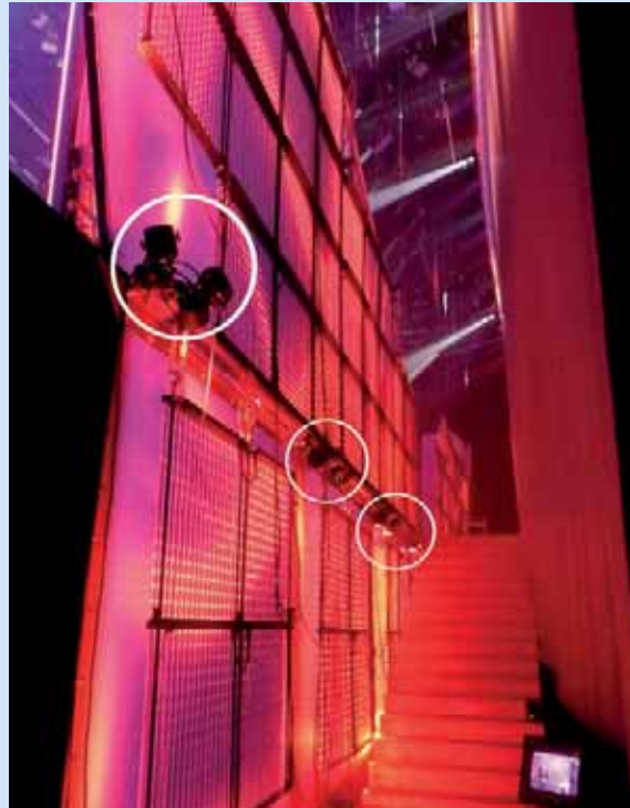
Die seitlichen Bühnenwände boten nur wenig Platz für Scheinwerfer und wurden daher mit LED-Rahmen von G-Lec hinterleuchtet. Im Kreis zu sehen: Die Positionierung der zusätzlichen „Spectra Wow“ von LDDE
