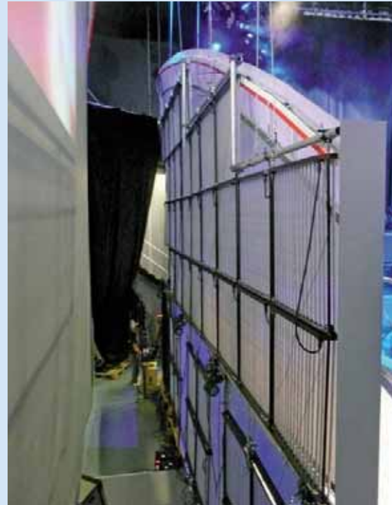
Die seitlichen Bühnenwände boten nur wenig Platz für Scheinwerfer und wurden daher mit LED-Rahmen von G-Lec hinterleuchtet. Im Kreis zu sehen: Die Positionierung der zusätzlichen „Spectra Wow“ von LDDE
