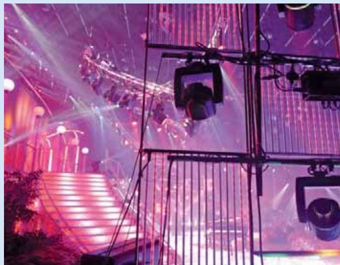
Die schachbrettartig angeordneten LED-Rahmen – dazwischen die Moving Lights
