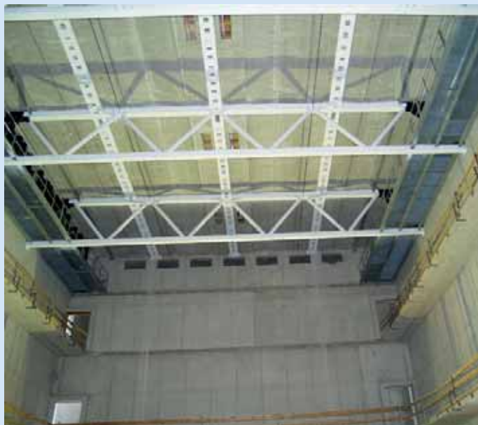
Schon der Rohbau vermittelt einen Eindruck von der Größe des Saales, der 1.260 Zuschauern Platz bieten wird
