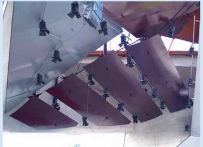
Die schwebenden Schallreflektoren
