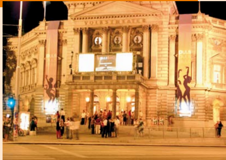
Das Endprodukt am Volkstheater: rechts und links je ein Leuchtkasten, in der Mitte eine Rückprojektion, Größe ca. 6 x 3 Meter (Projektor mit Zeitsteuerung und Zuspiegelung über DVD, die alle 3 bis 5 Tage upgedatet wurde).
