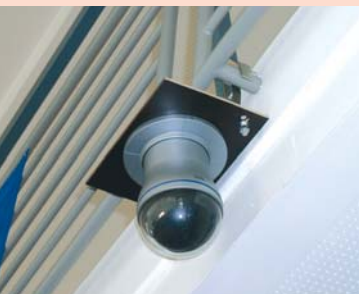
Positionierbare 1/4 Zoll Dome-Kamera mit Auto-Tracking
