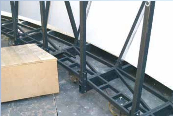
Die Außenhaut besitzt eigene Rollen und wird zum Drehen mit der Bühne verbunden
