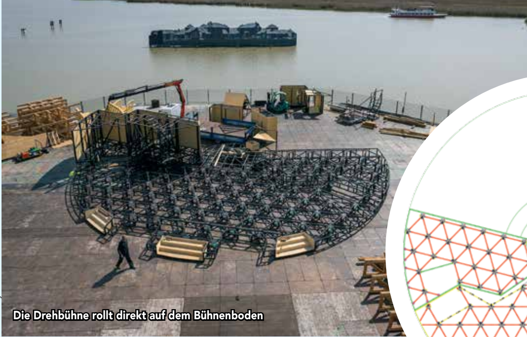
Grundriss der Drehbühne. Die beiden grün umrandeten Elemente können nach vorne geschwenkt werden. 200 Rollen stützen die gesamte Drehbühne
