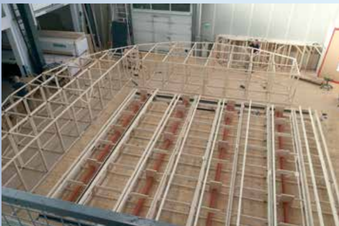
Die Unterkonstruktion mit den 4 Walzen
