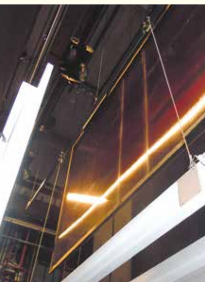
Die Abhängung am Schnürboden
