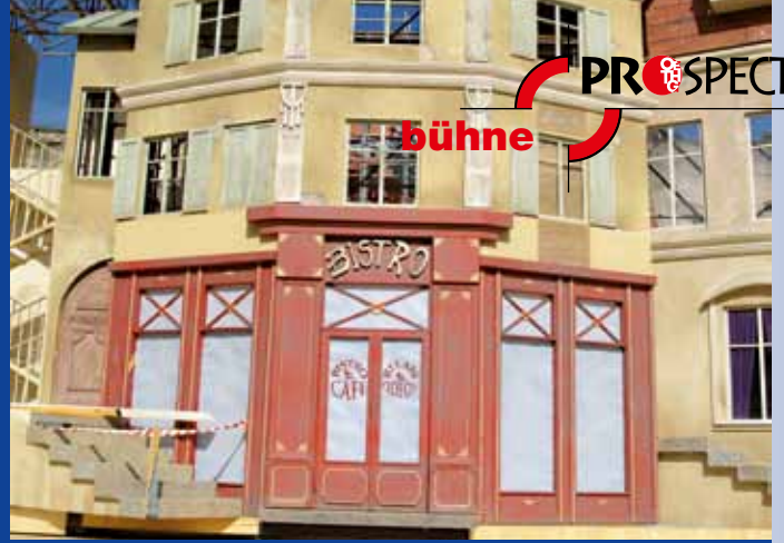
... und montiert im Steinbruch
