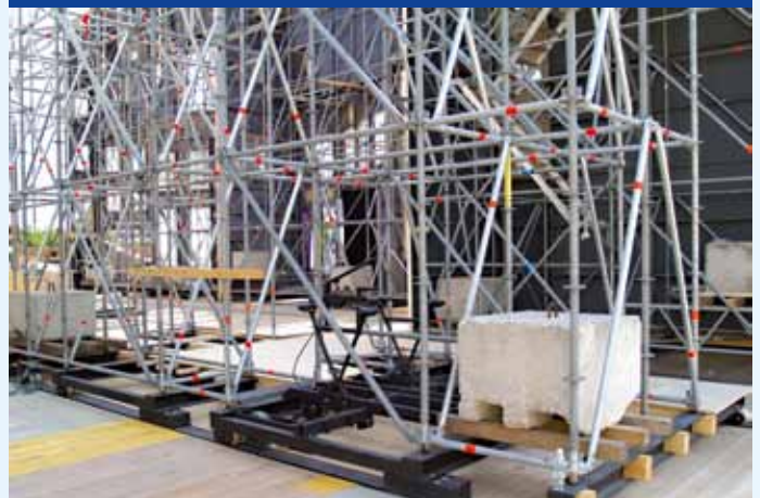
Rohrgerüst einer noch nicht verkleideten Kulissen mit Pedalantrieb; jeder Betonblock hat ein Gewicht von zirka 2,5 Tonnen
