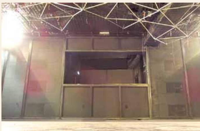
Deutlich zu erkennen die Anordnung der Basslautsprecher als Linien links und rechts und die Öffnung zum DJ-Platz
