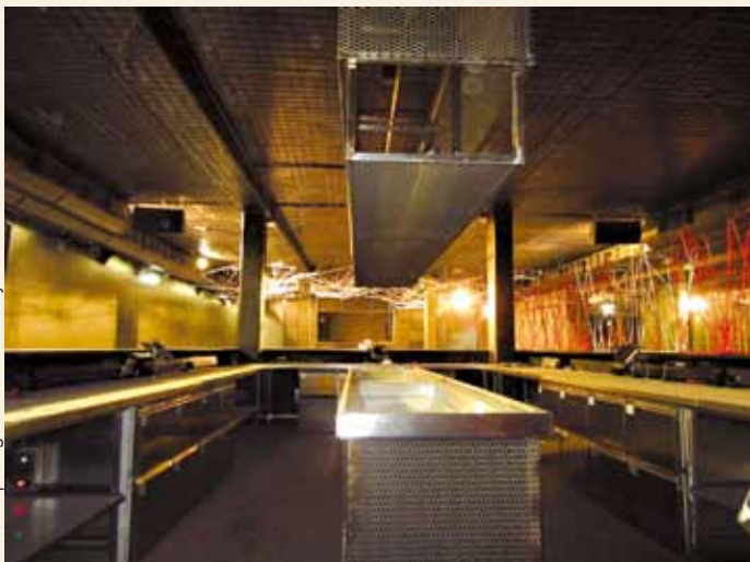
Der Klubraum hat die Form einer langen Schachtel
