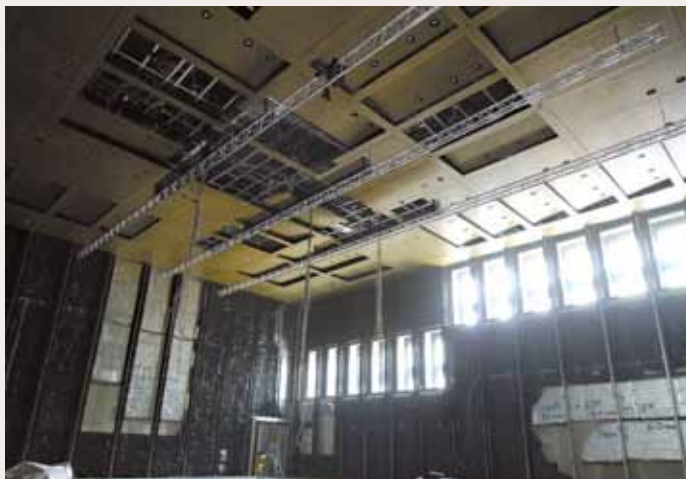
Der Orchesterprobesaal mit vormontierten akustischen Deckenelementen
