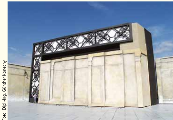
Das zentrale Bühnenelement „Portal“, welches um eine links außen situierte Achse drehbar ist
