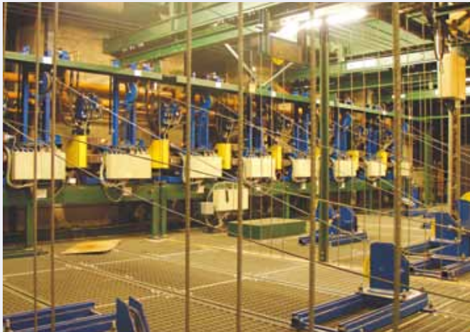
Die Winden am Schnürboden, an deren Seilen die Darsteller hängen
