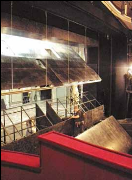
Die Tragformteile für die Bühnenplatte werden verschraubt
