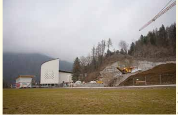
40.000 Kubikmeter Fels mussten vor dem eigentlichen Baubeginn abgetragen werden
