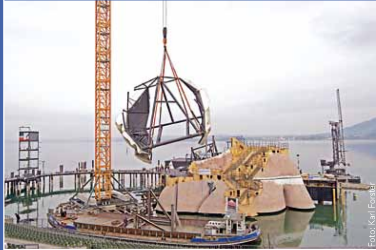
Aufsetzen eines der Kopfteile per Kran; deutlich ist am Lastkran der speziell angefertigte Transportbock zu erkennen
