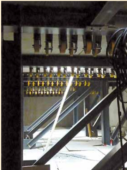
Ein erster Blick auf den Schnürboden
