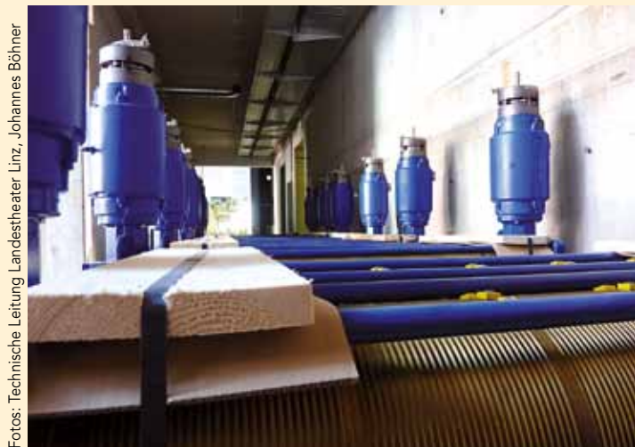
Die Zugwinden sind bereits montiert
