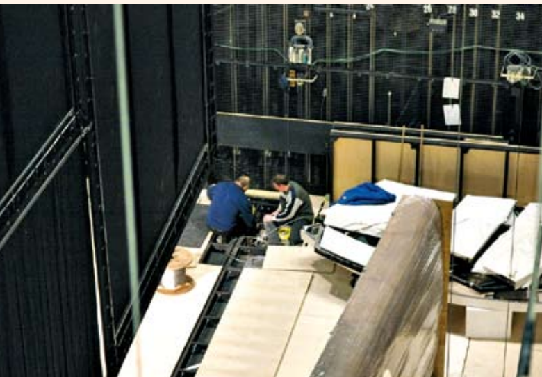
Einer der beiden Getriebemotoren mit Seilwinden zum Bewegen von Kulissenteilen wird in den doppelten Boden eingebaut
