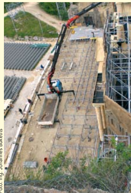
Vor dem Tempel des Sarastro wird die Unterkonstruktion mit den Schienen errichtet, auf denen dann die große Tempelkonstruktion mit dem Löwenkopf auseinanderrollen kann
