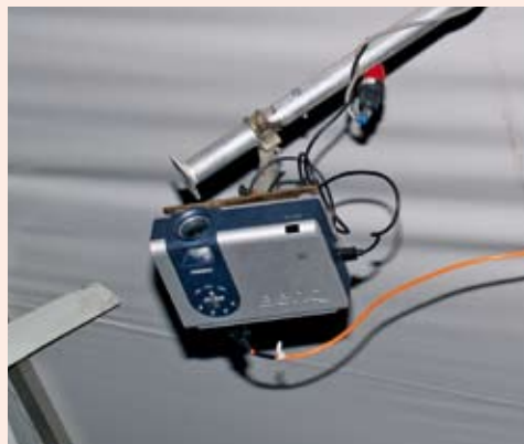
Einer der beiden Projektoren im Zuschauerraum mit 4.000 ANSI-Lumen
