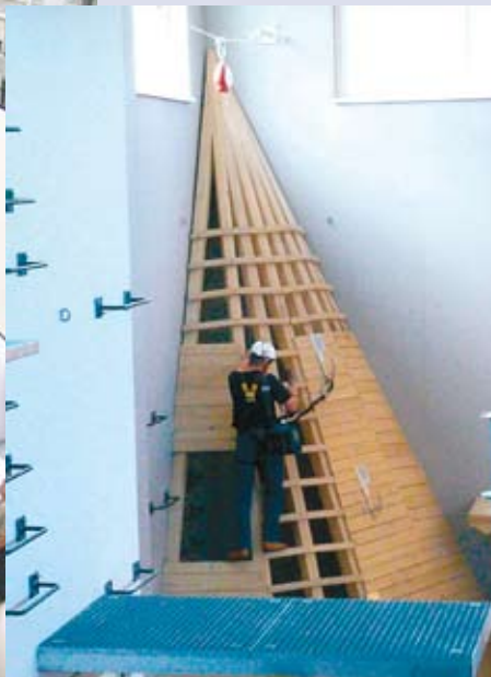
Besteigen eines Kirchturmdaches
