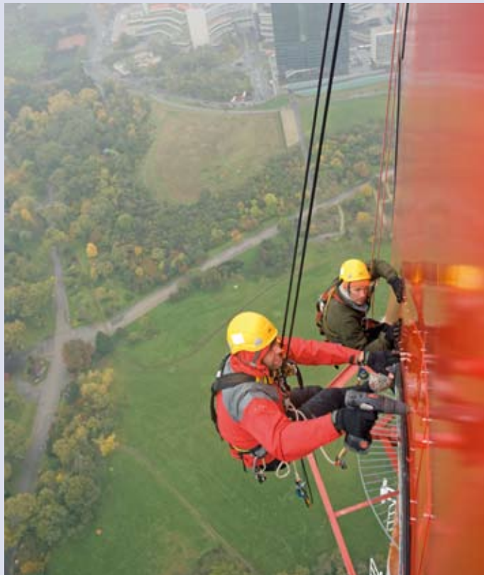
Arbeiten am Donauturm in luftiger Höhe
