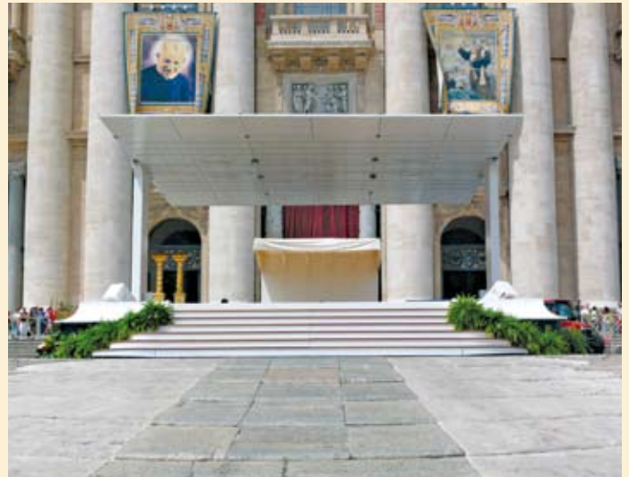
Das fertig aufgebaute mobile Podium vor dem Petersdom
