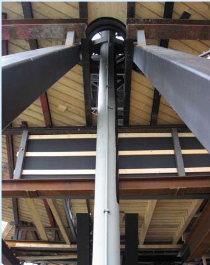
Einer der Antriebszylinder für die Augenwand (Durchmesser 350 mm, Länge 7,5 m)
