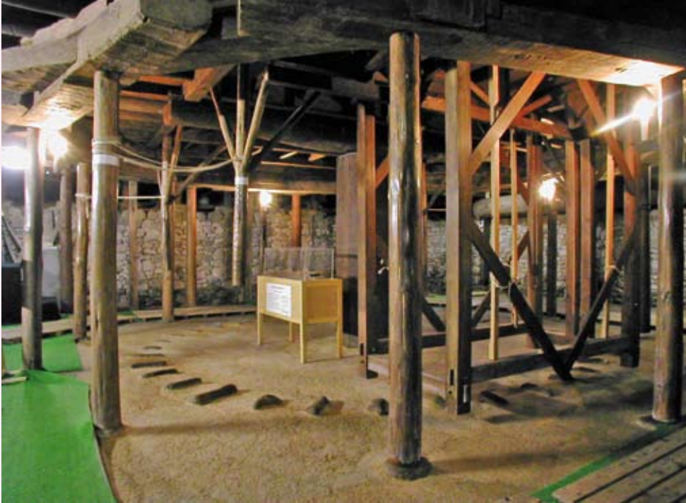
Die Unterbühne mit den Steinen, an denen sich die Bühnenarbeiter beim Bewegen der Drehbühne abstimmen konnten.
